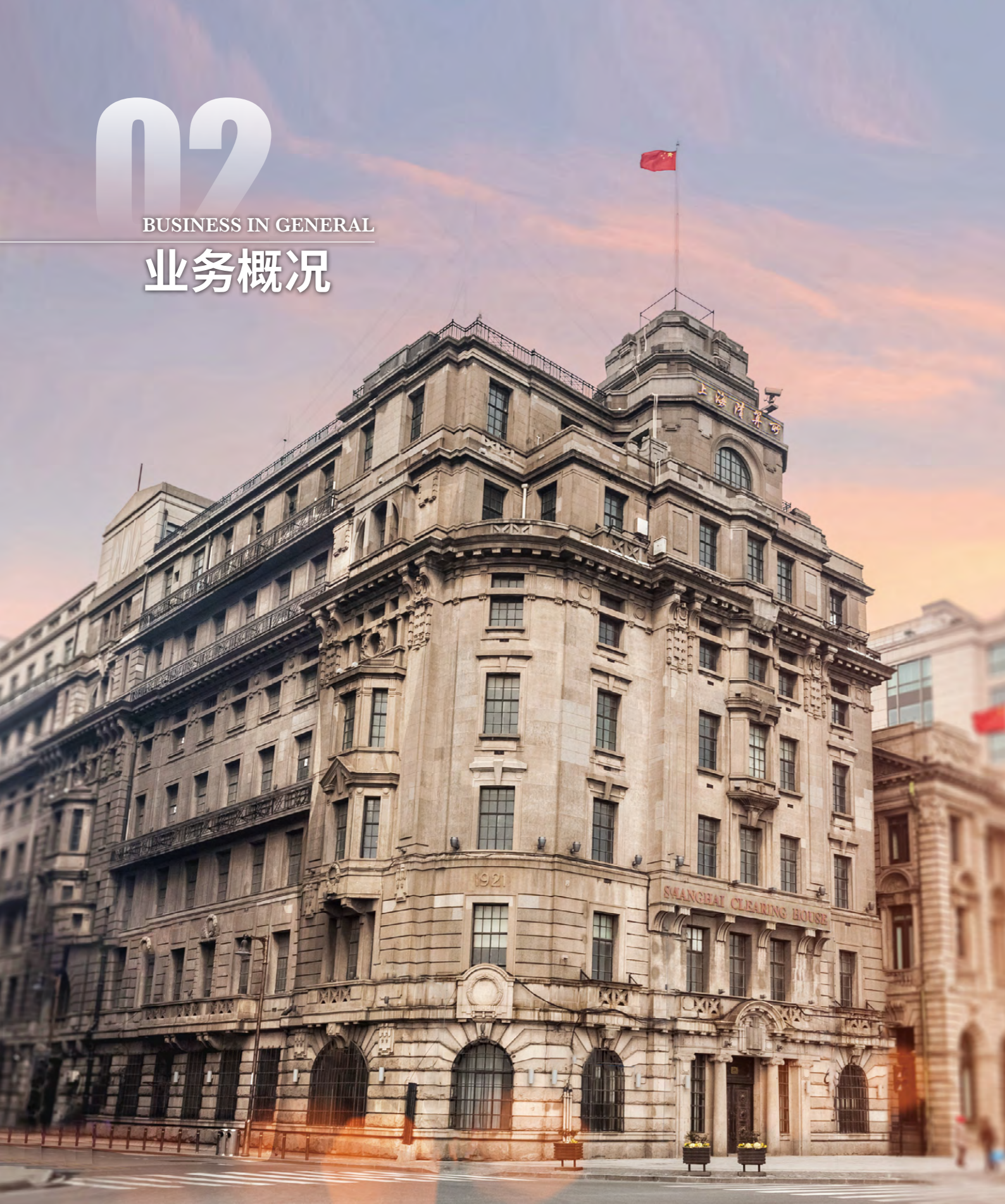
上海清算所大楼整体采用英国新古典主义建筑风格，融合巴洛克和文艺复兴等多种风格。基座饰面采用大花岗石砌筑而成，主入口大门仿帕拉蒂奥组合，两边设置2根爱奥尼克立柱，中部及上部采用平拱门窗，顶部退台成塔状造型，形同一艘巨轮屹立于外滩之畔。
